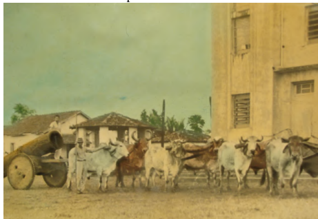
Figura 7: Construção da Igreja Matriz de Heitorai (déc. 1950)
